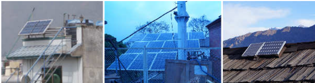
Abbildung 4-1 Abbildung links: Spanngurt über dem Modul führt zu erheblichen Verschattungsverlusten, Abbildung Mitte: Masten der Windkraftanlage führt zu erheblichen Verschattungsverlusten, Abbildung rechts: zwei unterschiedliche Module sind in Serie miteinander verschalten
